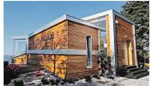
Lärchenholzfassade mit Alu-Bandelementen
